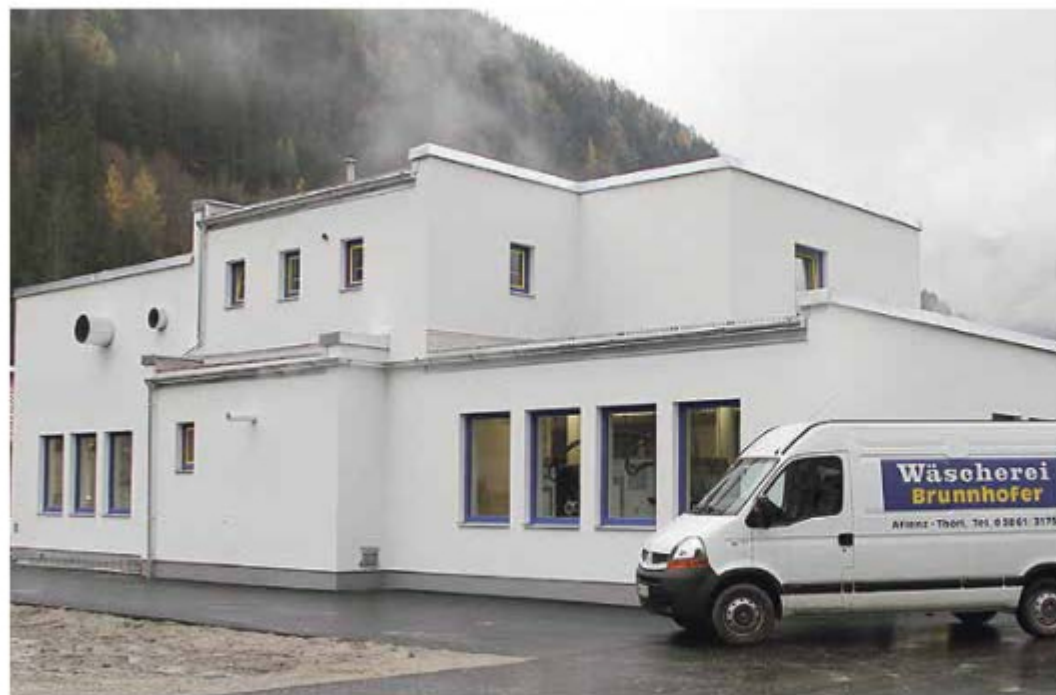
Mit dem Neubau in Thörl hat die Wäscherei Brunnhofer ihre Tageskapazität von 1,4 auf drei Tonnen erhöht. Foto: Brunnhofer
